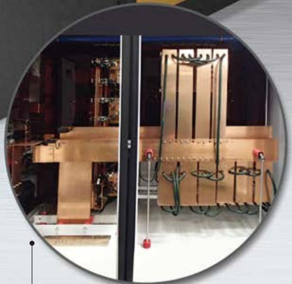
La imagen muestra la disposición del inversor y el capacitor del suministro de energía por inducción AMELT.
